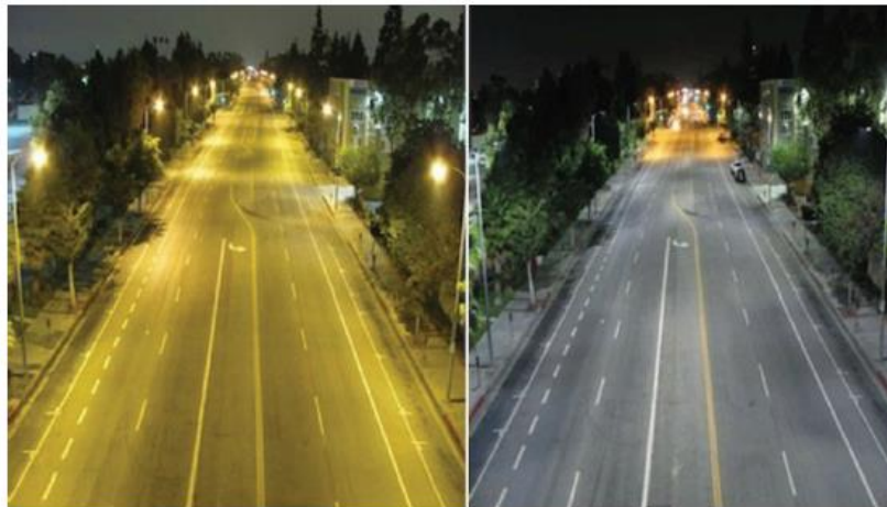
Figura 130 - Comparação entre trecho utilizando tecnologia Vapor de Sódio a esquerda e tecnologia LED a direita
